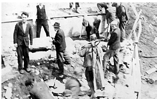
Práce na stavbě provizorního mostu na Dolním konci
