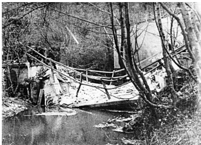
Vyhozený most přes Olešnou na Dolním konci 5. 5. 1945
