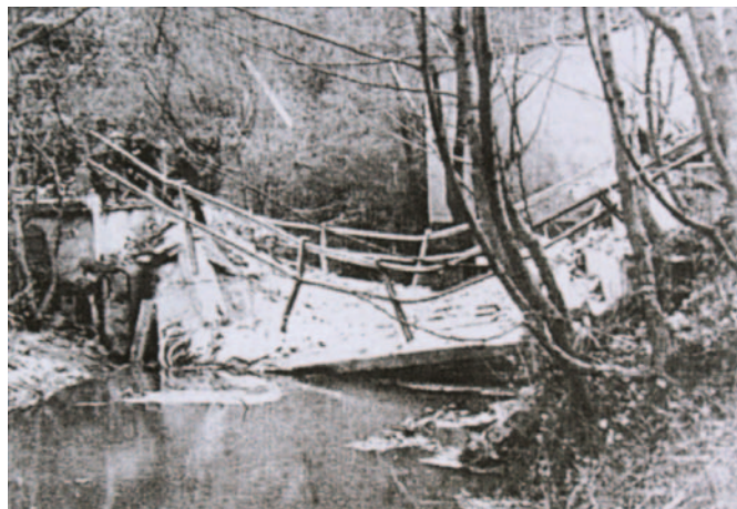
Vyhozený most přes Olešnou na Dolním konci
