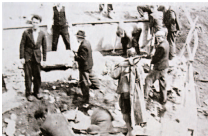
Práce na stavbě provizorního mostu
